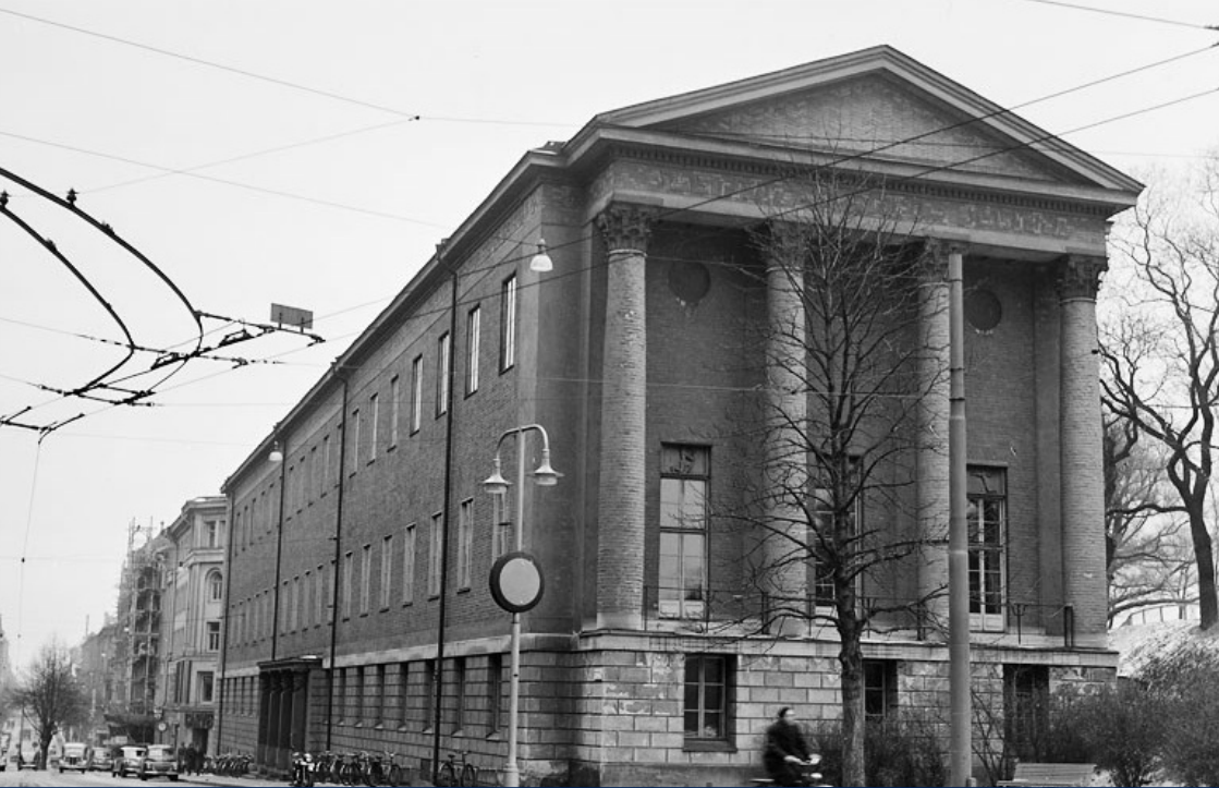
Norrtullsgatan 2. Byggnaden uppfördes 1925-27 och donerades till Stockholms högskola från Stockholms stad. Fotograf: John Kjellström. Stockholms stadsmuseum
