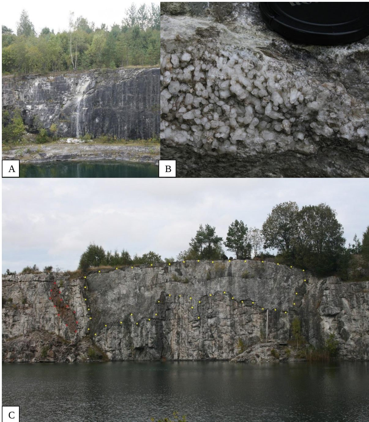
Bild 9: A) Del av den stora sprickan på sydvästra delen i Fagerhult är instabil och det syns på bilden att det nyligen skett ett ras. Det omkringliggande berget är mycket omvandlat och mjukt och går att smula sönder mellan fingrarna B) Stora välbildade kvartskristaller som hittades inuti sprickan (A) där ett block hade fallit ner. Observera kameralinsskyddet för skala. C) Norra sidan av Fagerhult visar sprickplanet av en spricka som går parallellt med dagbrottet (Gult) och det stora granitboudinaget (Rött).
